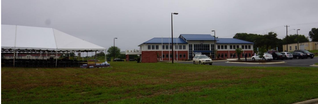
Blick auf das Verwaltungsgebäude, links (beim Zelt) wird die Trainingshalle entstehen
